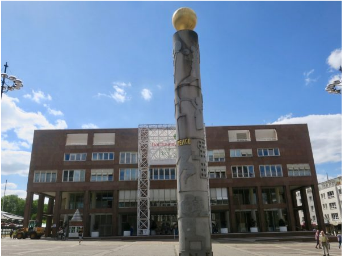
Wird bald umfassend renoviert: das neue Rathaus von 1989 am Friedensplatz mit Friedenssäule. (Foto: Bernd Berke)
