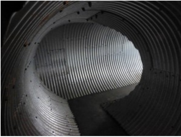
Licht am Ende des Tunnels
