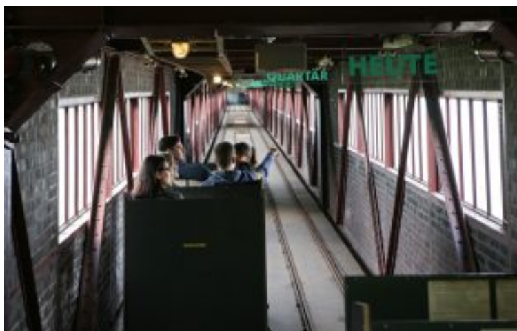
Hier geht's los: Die Standseilbahn im historischen Schrägaufzug der Kokerei Zollverein (Bild: Ruhrmuseum)
