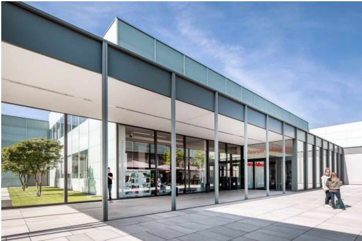
Außenansicht des Museums Folkwang in Essen (Eingangsbereich). (Foto: Giorgio Pastore)
