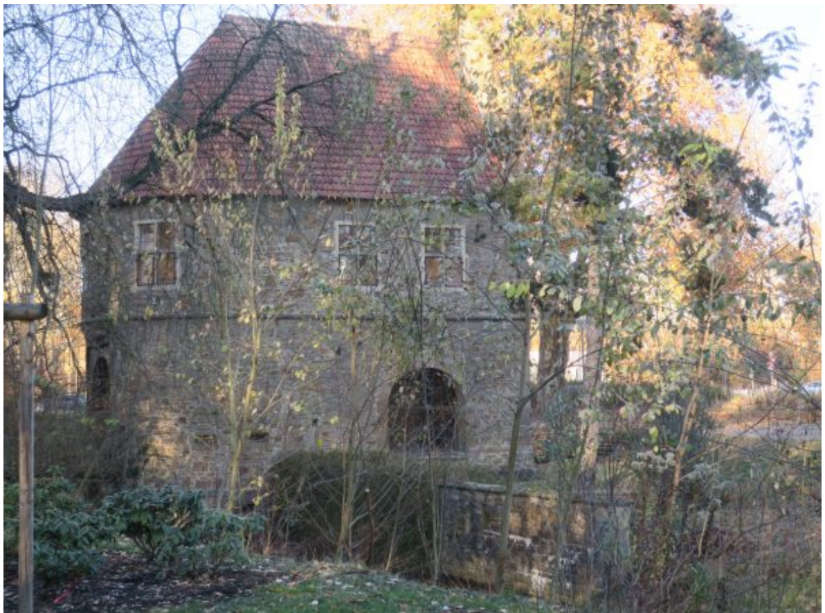
Ansicht des Torhauses im Rombergpark. (Foto: Bernd
