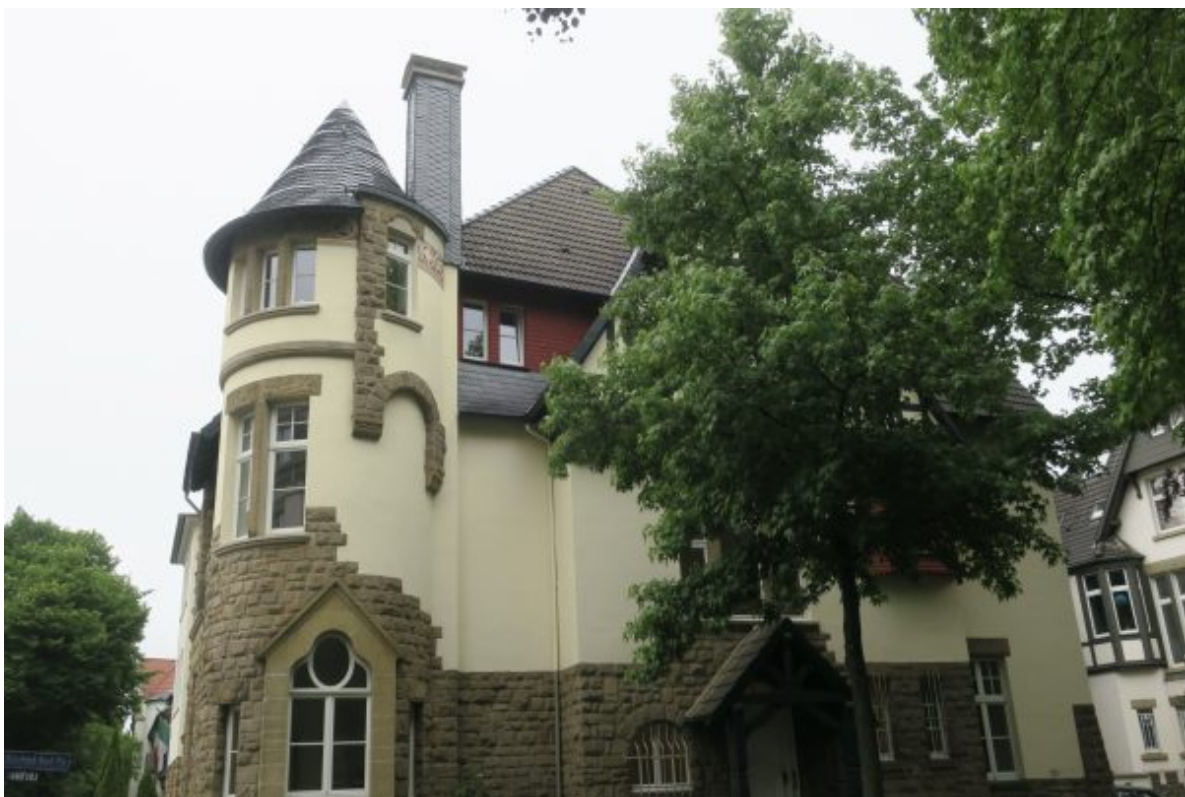
An der Ecke Prinz-Friedrich-Karl-Straße/Goebenstraße: ein Haus im sogenannten „Heimatstil“. (Foto: Bernd Berke)
