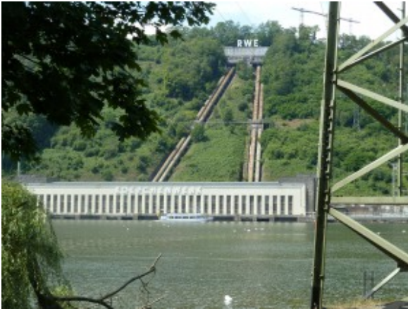
Ansicht des Koepchenkraftwerks am Hengsteysee zwischen Dortmund, Hagen und Herdecke. (Foto: Bernd Berke)
