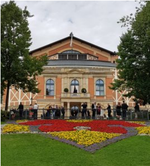
Die frisch renovierte Fassade des Festspielhauses. Foto: Werner Häußner
