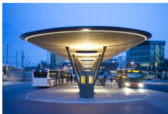
Busbahnhof in Unna. (Foto: BDA)
