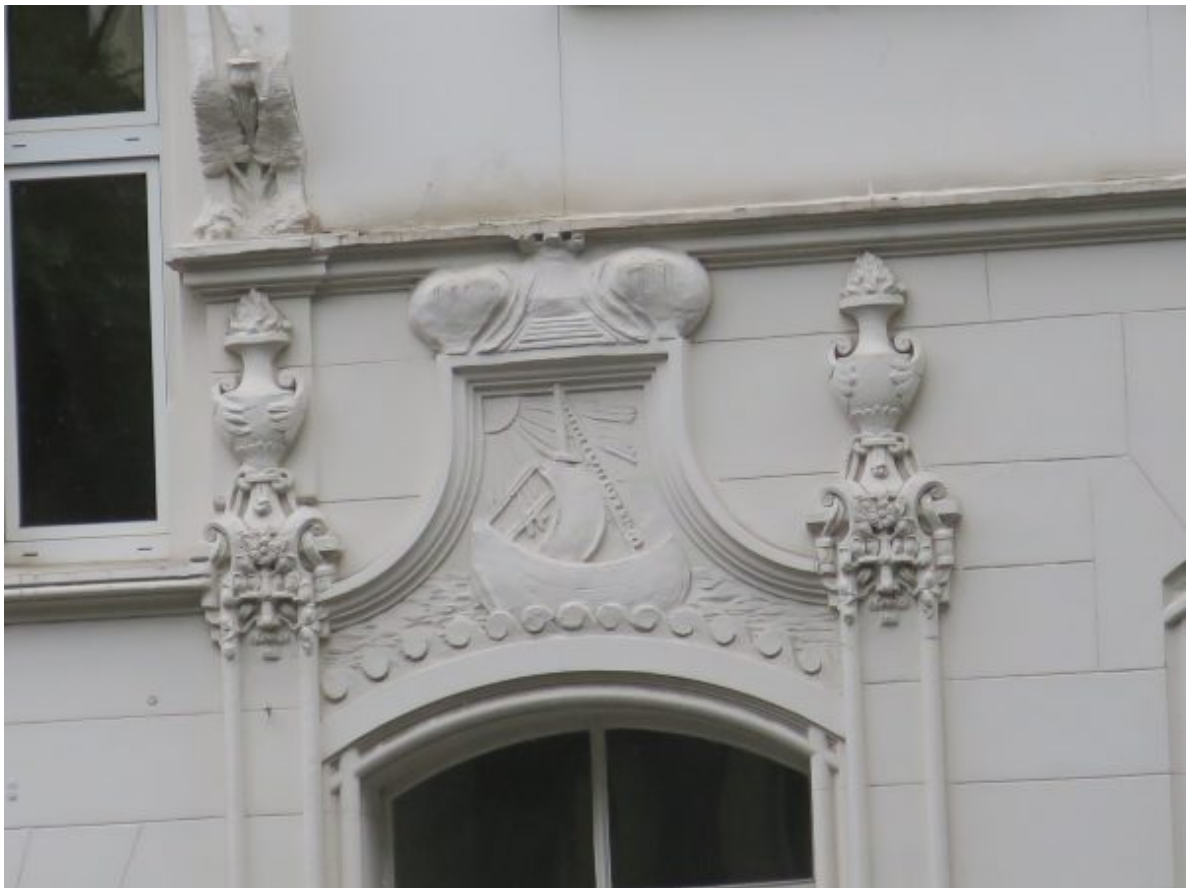
Die Hansekogge ziert nicht von ungefähr eine weitere Fassade in der Kaiserstraße. (Foto: Bernd Berke)
