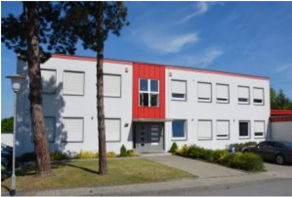
Unscheinbar: das ehemalige Bergmann-Verlagshaus in Unna, Hochstraße 12. (Foto: Horst Delkus)
